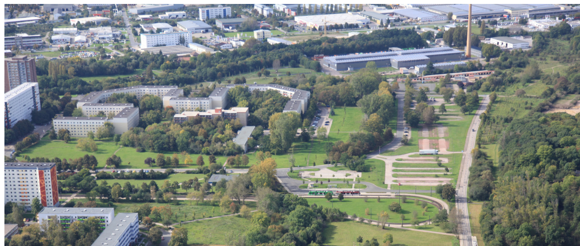
Blick auf die Rückbauflächen der Großwohnsiedlung Roter Berg von Osten
