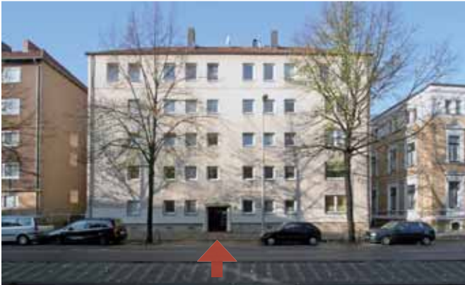
Nachkriegsbebauung: Erschließung von der Straßenseite
