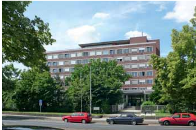
Das Gebäude des Finanzamtes aus den 60er Jahren springt als einziger Bau aus der Straßenflucht zurück.
