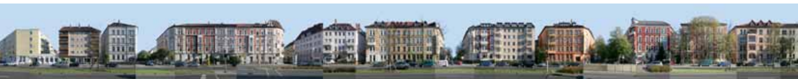
Abschnitt Mitte-Nord: Ansicht von Westen
