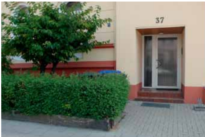
Die Abfallbehälter verschwinden optisch hinter einer Hecke, sind dem Blick im Eingangsbereich aber leider nicht komplett entzogen.
