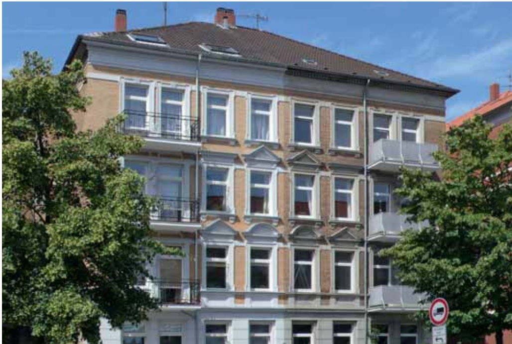
links, positiv: filigrane Balkongeländer aus Metall / rechts, negativ: flächig wirkende Balkongeländer
