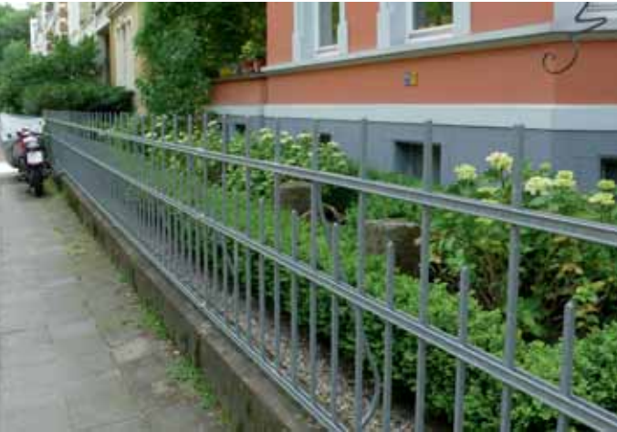
Einfriedungen als Zaun, Jasperallee
