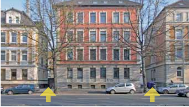
Gründerzeithaus: Erschließung über die Bauwiche
