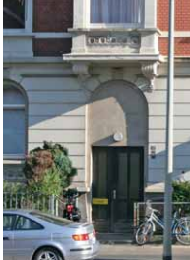
Die »neue« Tür ist niedriger, das Oberlicht zugemauert
