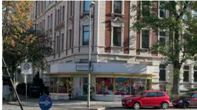
Hagenring, Ecke Roonstraße: Umbau des Erdgeschosses
