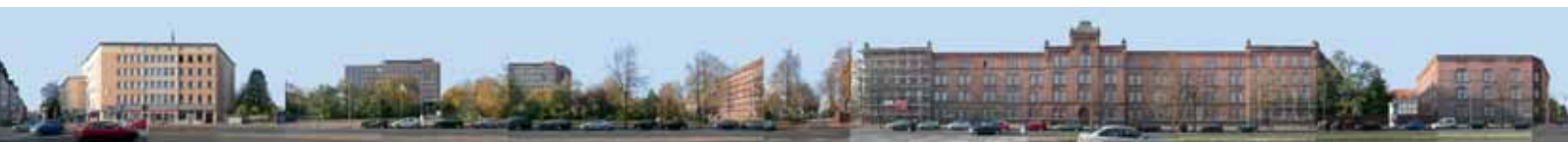
Abschnitt Mitte-Süd: Ansicht von Osten
