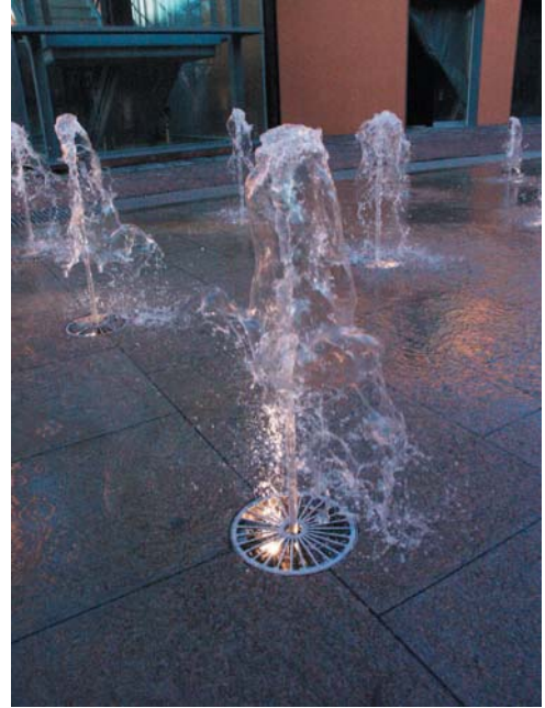
Norden [Firma: KFS-Springbrunnentechnik, Anlagenbau GmbH, Detmold]
