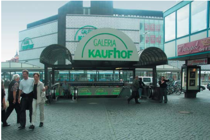
Konzept und Gestaltung Bohlwegtunnel – in die Jahre gekommen.
